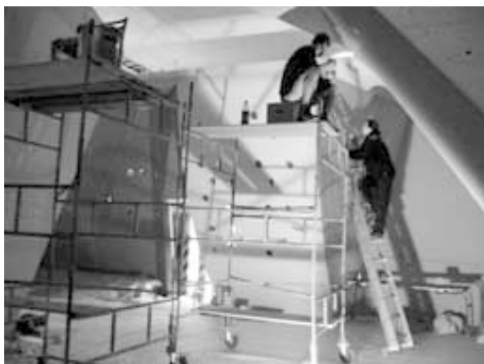
Práce v interiéru nové boulderové haly.
