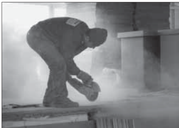
Na dokončovacích pracích se podílí 260 řemeslníků nejrůznějších profesí.
