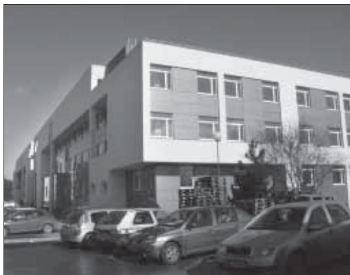
Výstavba Integrovaného objektu je největší investiční akcí VUT v Brně v jeho novodobé historii.
