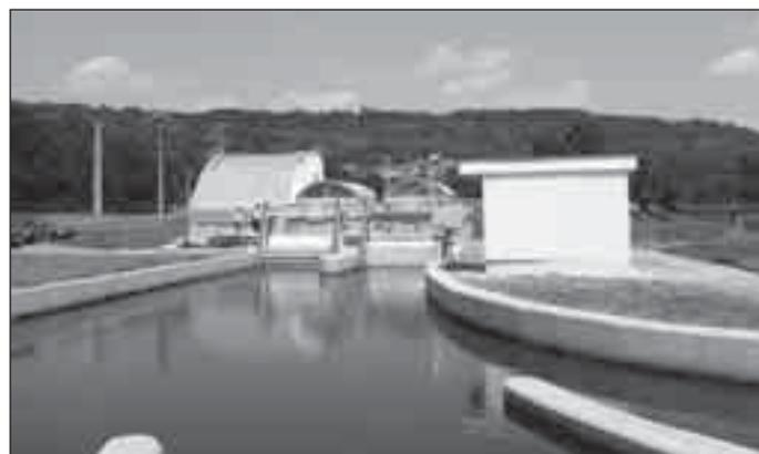
Elektrárna Ivančice, dvě soustrojí přímoproudých turbín, výkon 160 kW, celkem 320 kW, přivaděč i turbíny navrhlo VUT v Brně.
