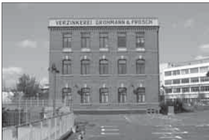
Konverze původně výrobních objektů na administrativní budovy ve čtvrti Plagwitz.
