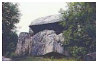
Obrovité bloky železobetonu brání vstupu do podzemí "Vlčího doupete".
